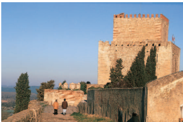
Paseo por la ronda de la muralla de Ciudad Rodrigo.
