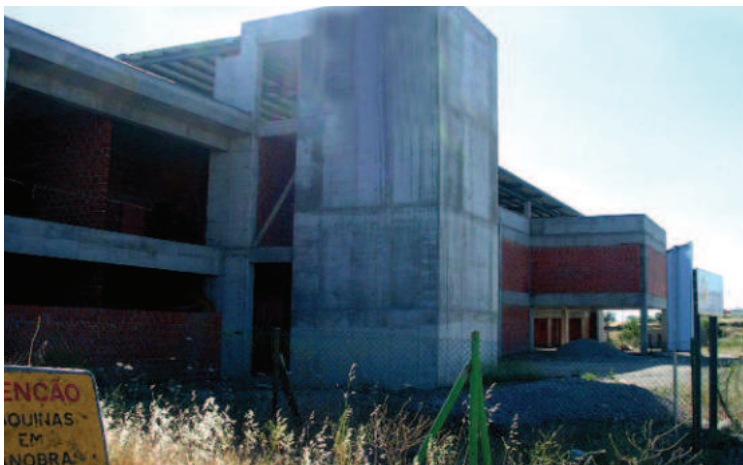
Parque empresarial en construcción en Vila Nova de Foz Côa.
