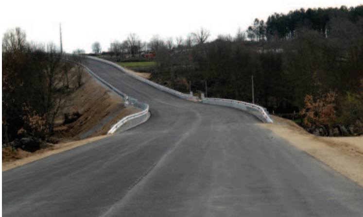
Estrada da obra variante a Aldeia da Ponte, E.N. 233-3 a fronteira, Sabugal.
