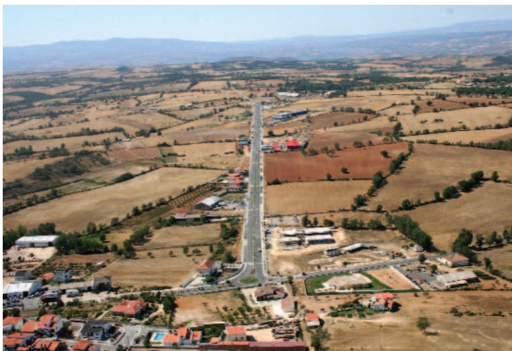
Recta Vale da Madre já executada, Mogadouro.
