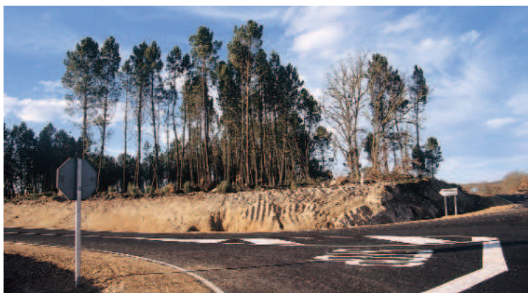
Estrada Navasfrias-Lageosa da Raia.
