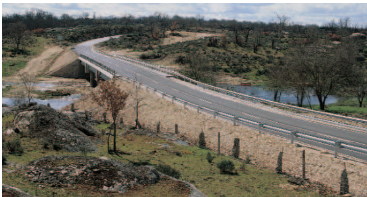
Puente sobre el río Uces, acceso a Cabeza del Caballo (Salamanca).
